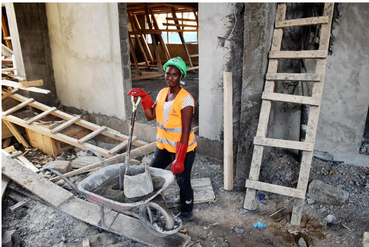
Gisèle NDAKANADE travaille sur l'un des chantiers HIMO du quartier Miskine © PRESU AGETIP-CAF
