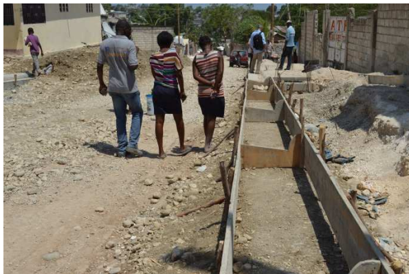
Travaux routiers, Carrefour
