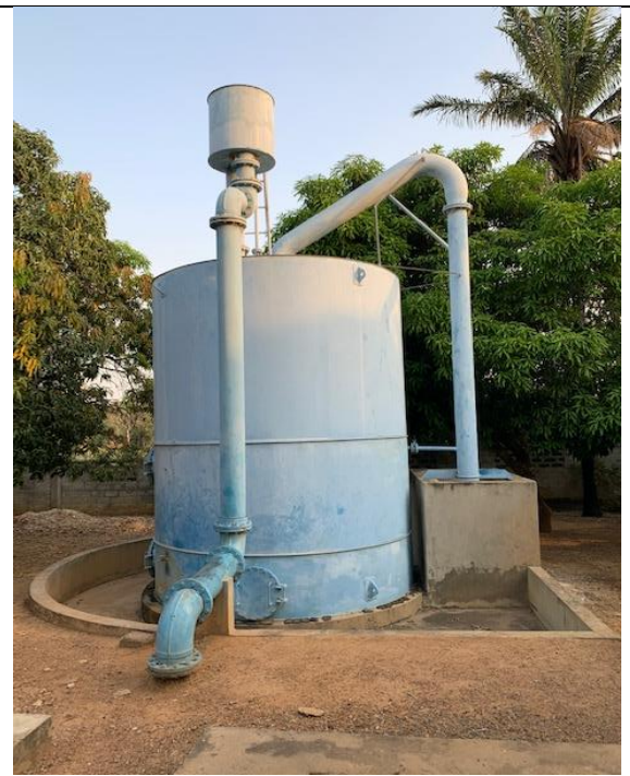
Envoi réseau (distribution gravitaire)
