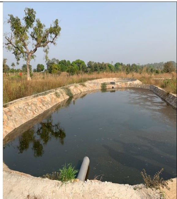
GBV - Bassin de récupération Lixivia
