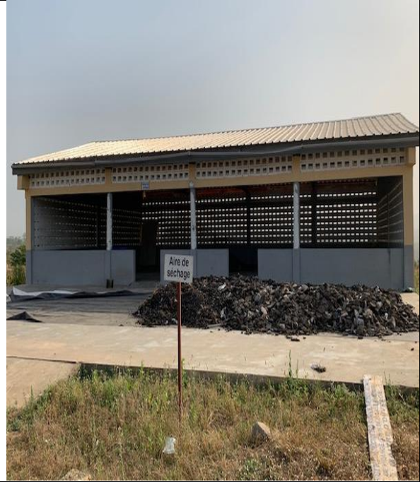
Aire séchage / stockage
