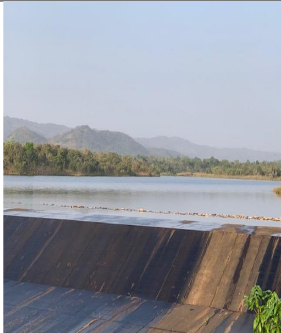
Barrage de retenue (rétention sédiments)
