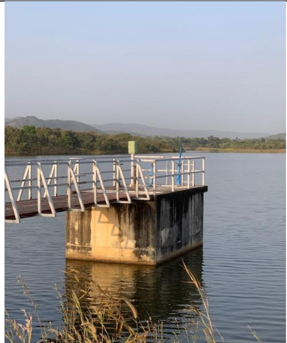
Prise extraction eau barrage de retenue
