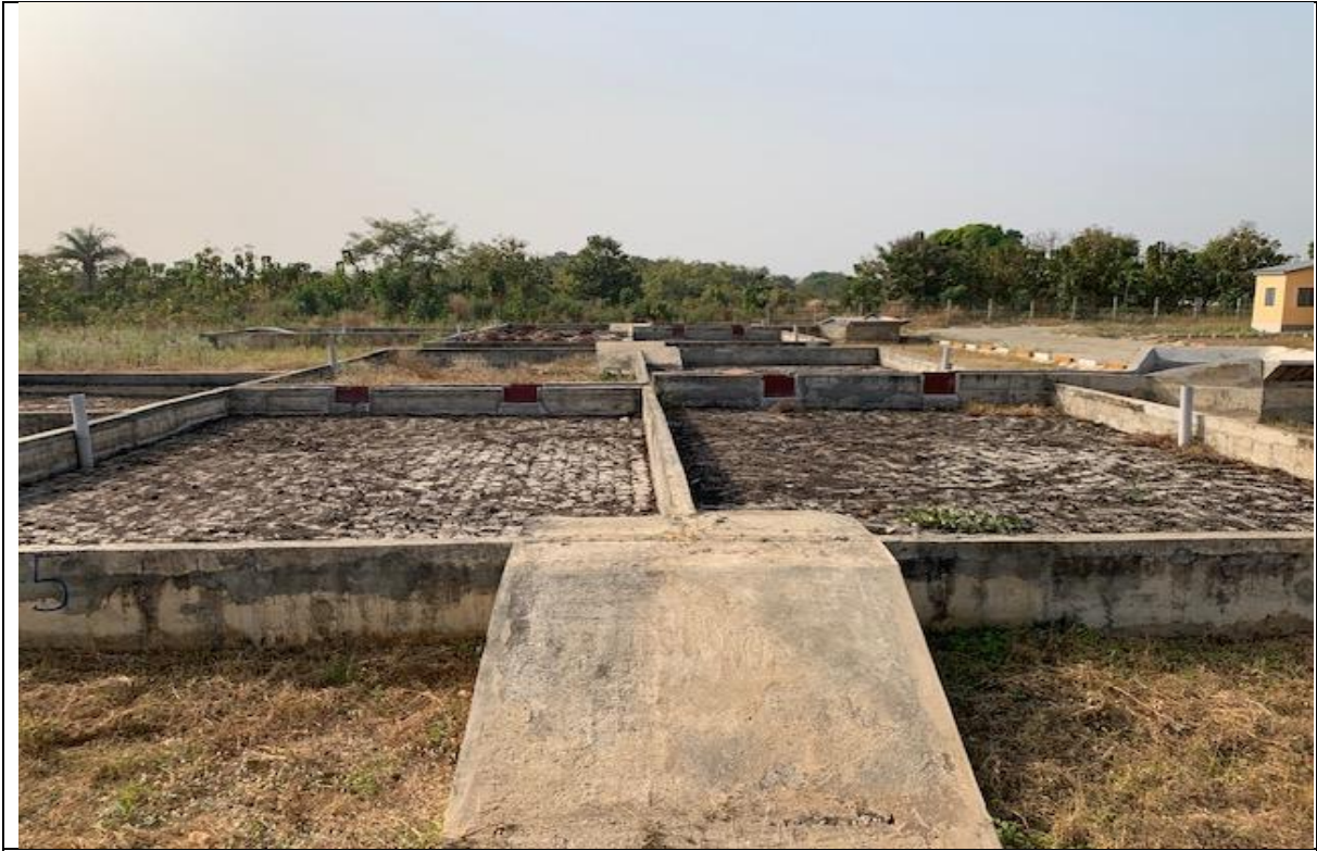
GBV – Station de traitement des boues de vidange
