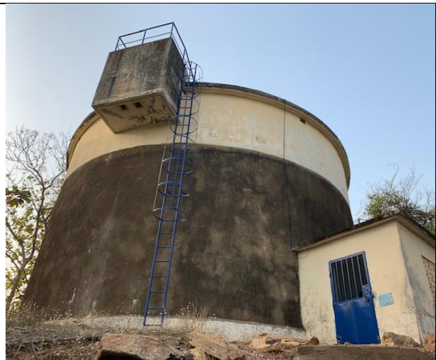
Château d'eau / Distribution gravitaire
