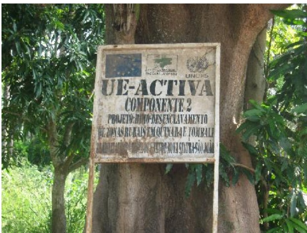
Visibilité: panneau de chantier
