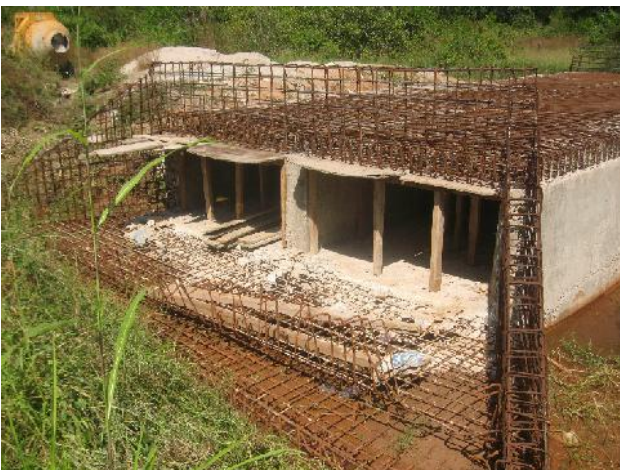
Travaux en cours sur dalot triple.
