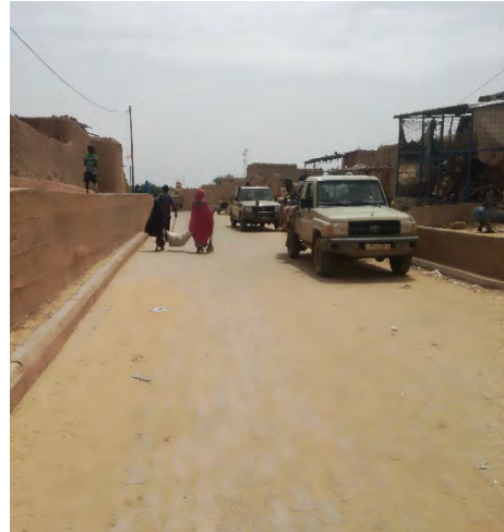
PK 60 – Pavage au village de Takanama
