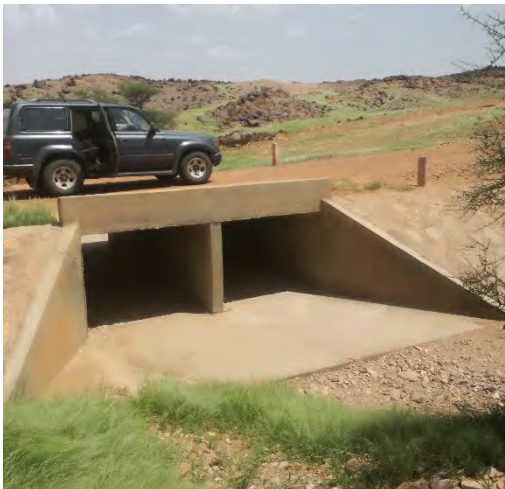
PK19,5- Dalot triple en bon état
