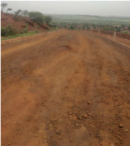
PK19,1- Entrée de Barmou- Ravinage de la route- Fossés maçonnés en bon état
