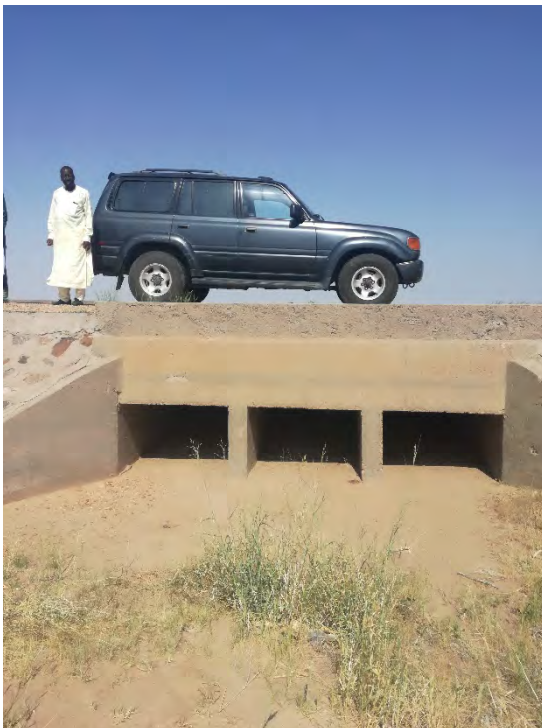
Dalot en bon état structurel et bien curé
