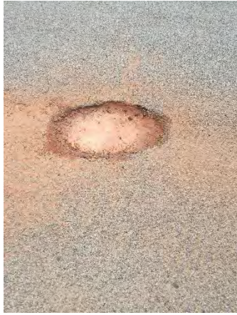
Apparition de quelques nids de poule
