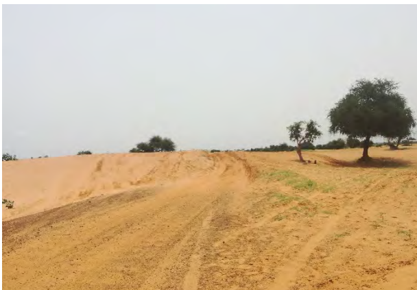
PK31,5- Dune coupant la route et source d'accidents
