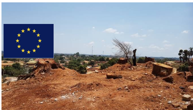
Figure 5: Etat de construction des logements des personnels administratif Nzérékoré, mars 2019
