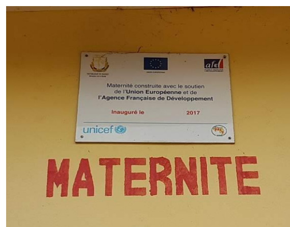
Figure 7: Plaque sur bâtiments construits
