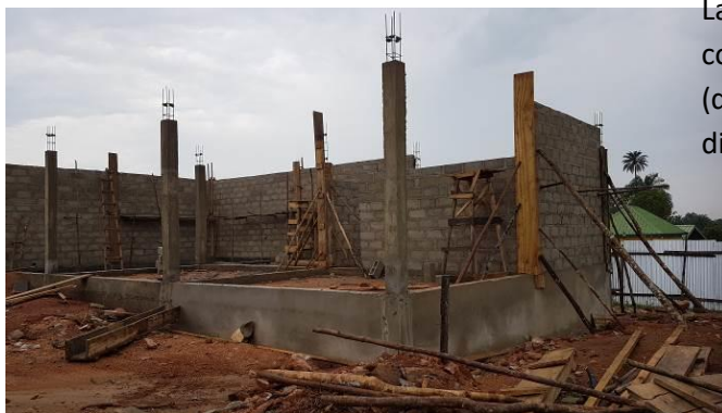
Figure 4: Etat de la construction de la PCG Nzérékoré (mars 2019)
