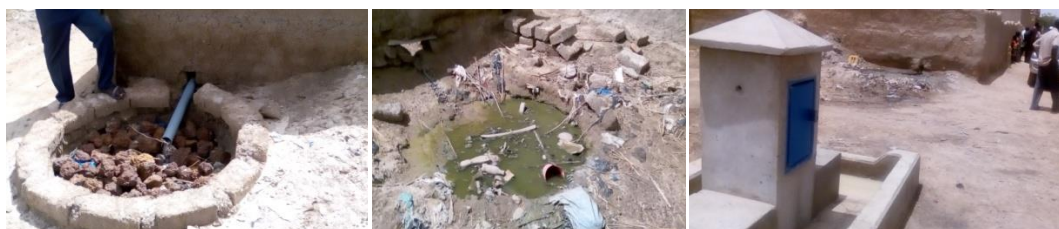
Figure 5 : Une fosse dans la rue, pour éviter d'avoir des eaux polluées près des Bornes Fontaines (Diena, Ségou, 28/06/16)
